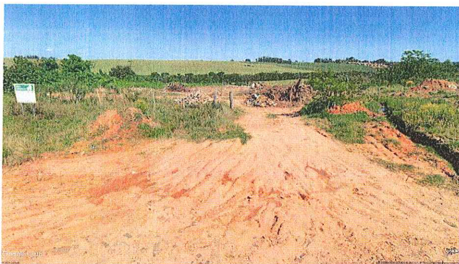
Imagem 05: Área de bota-fora, vista frontal.
